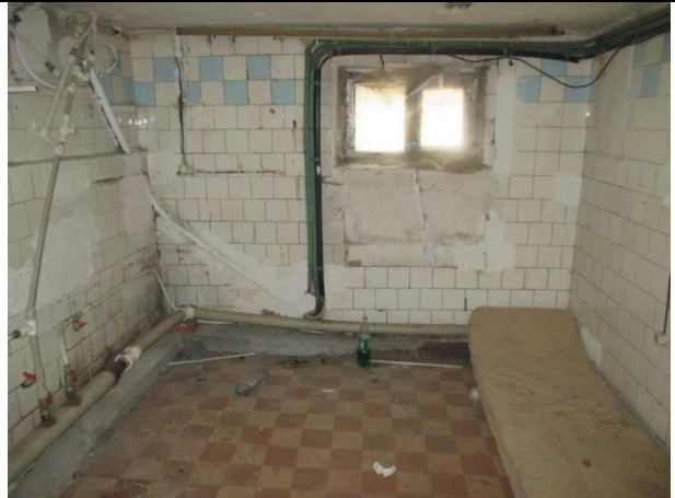
Фото № 19 – Внутреннее состояние помещения
