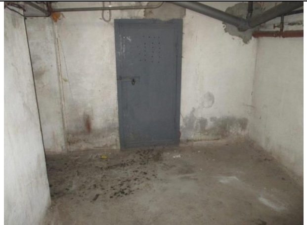
Фото № 16 – Внутреннее состояние помещения
