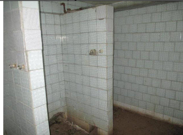
Фото № 33 – Внутреннее состояние помещения
