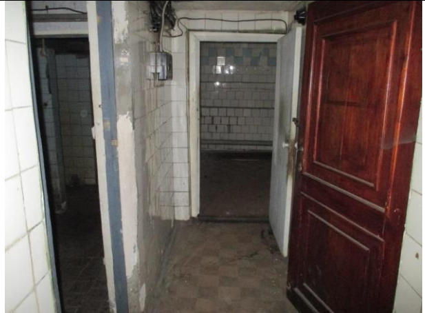
Фото № 17 – Внутреннее состояние помещения
