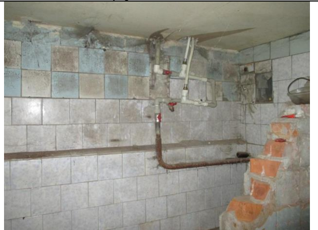
Фото № 34 – Внутреннее состояние помещения
