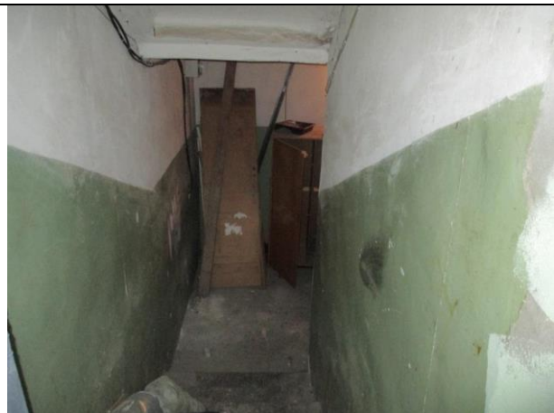
Фото № 8 – Внутреннее состояние помещения
