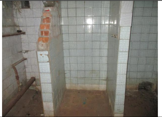
Фото № 32 – Внутреннее состояние помещения
