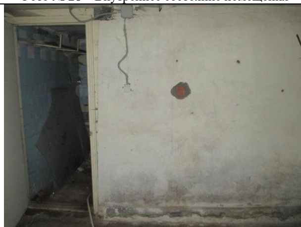
Фото № 28 – Внутреннее состояние помещения
