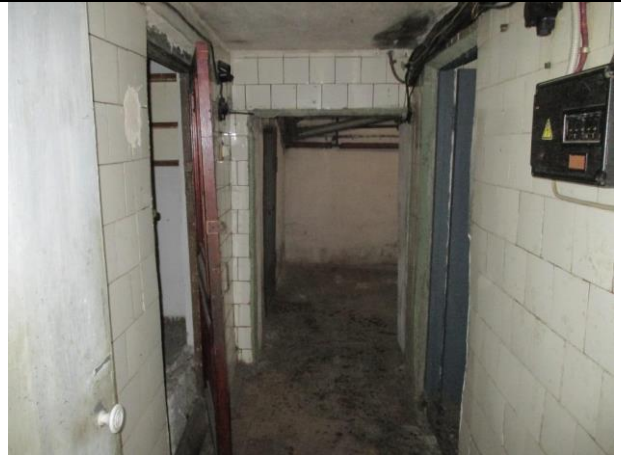
Фото № 20 – Внутреннее состояние помещения
