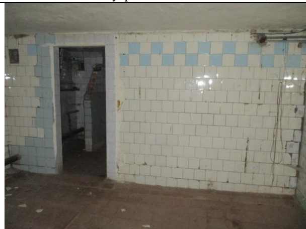
Фото № 30 – Внутреннее состояние помещения
