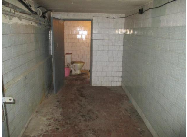
Фото № 21 – Внутреннее состояние помещения
