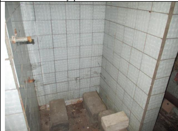
Фото № 25 – Внутреннее состояние помещения
