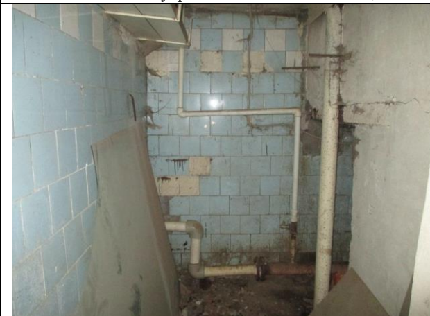
Фото № 29 – Внутреннее состояние помещения
