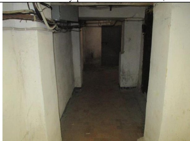
Фото № 14 – Внутреннее состояние помещения
