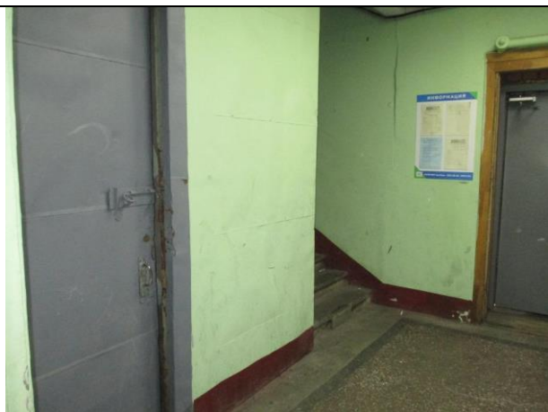
Фото № 6 – Проход к помещению (через парадную)
