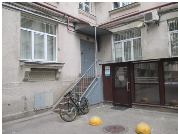
Фото № 5 – Общий вход в помещение
