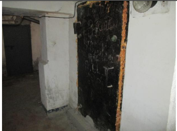
Фото № 15 – Внутреннее состояние помещения
