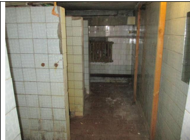
Фото № 23 – Внутреннее состояние помещения
