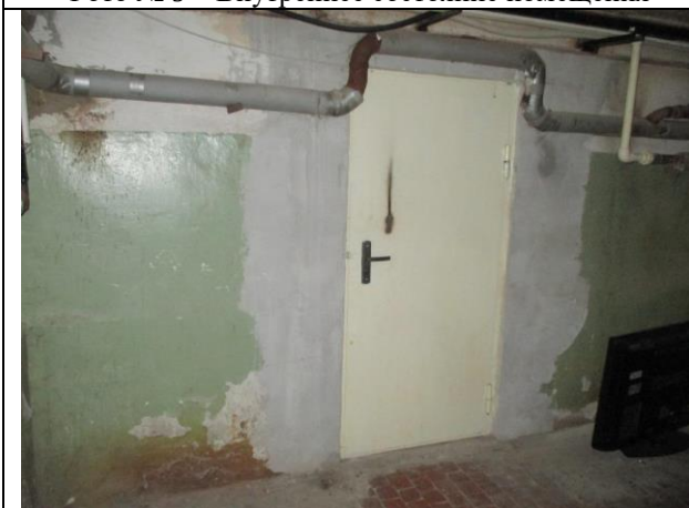
Фото № 11 – Внутреннее состояние помещения
