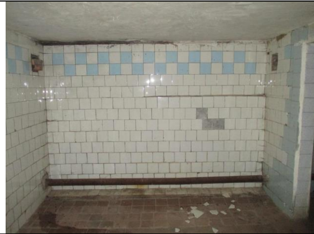
Фото № 31 – Внутреннее состояние помещения
