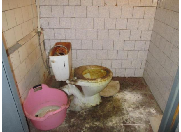
Фото № 22 – Внутреннее состояние помещения
