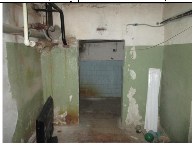
Фото № 12 – Внутреннее состояние помещения
