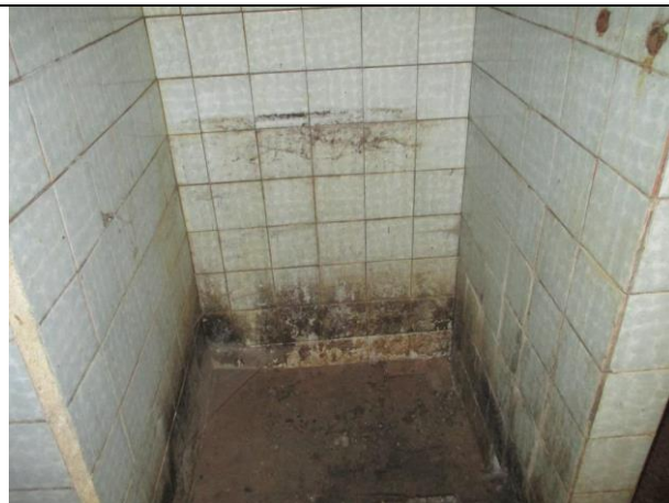
Фото № 24 – Внутреннее состояние помещения
