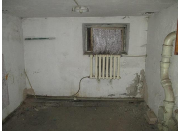
Фото № 18 – Внутреннее состояние помещения
