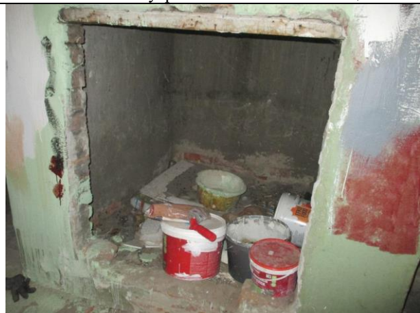
Фото № 10 – Внутреннее состояние помещения
