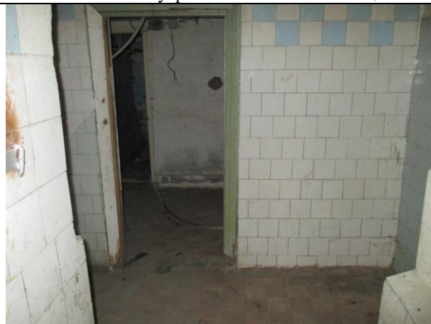
Фото № 26 – Внутреннее состояние помещения
