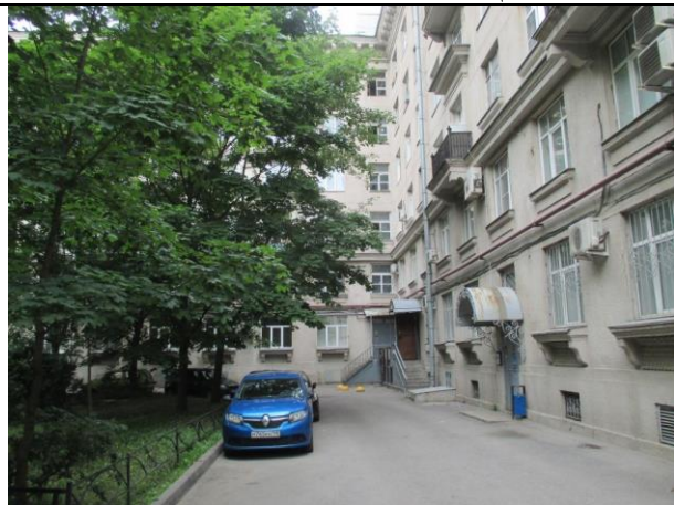
Фото № 1 – Ближайшее окружение и подъездные пути
